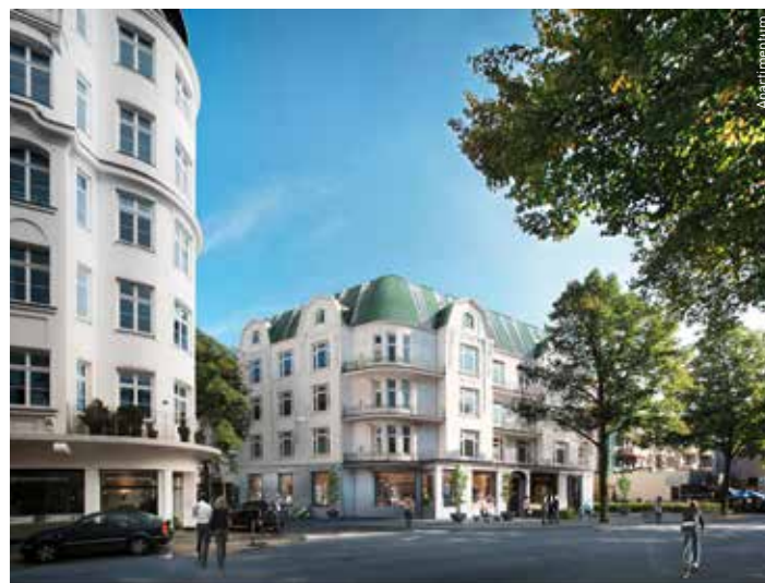
Im Mehrfamilienhaus Apartimentum steuert der Bewohner die Wohnung über das Smartphone.
